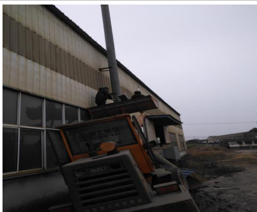
浸漆有机废气排气筒出口
